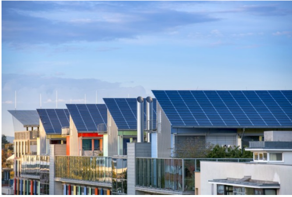
Häuser mit Photovoltaikanlagen in Freiburg. Foto: Gyula Gyukli-fotolia
