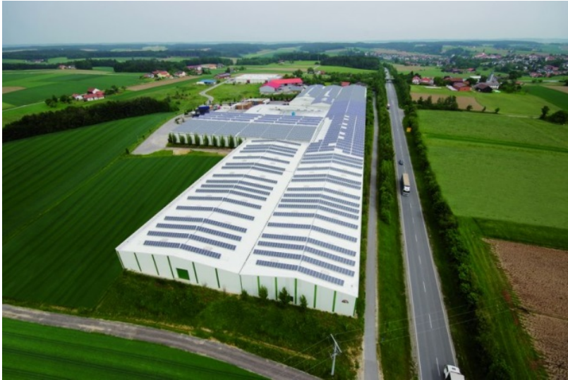
Photovoltaikanlage auf einem Firmendach in Simbach.
