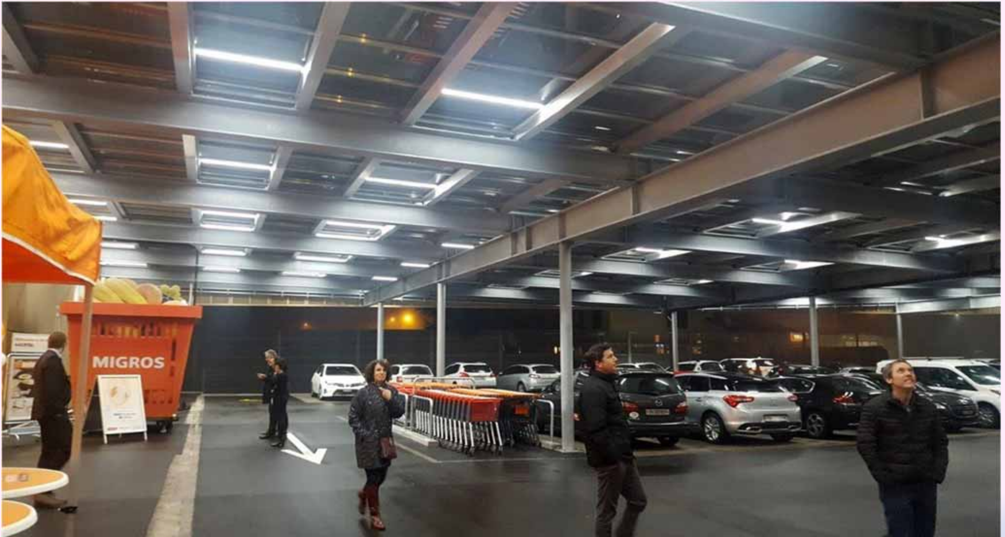
Amriswil MIGROS, Schweiz – 170 kWp – 1.300m 2
