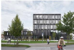
Abbildung 4: Institutgebäude des ZSW in Stuttgart, das auf drei Seiten eine PV-Fassadenanlage sowie eine PV-Dachanlage besitzt.
