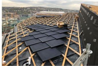
Abbildung 10: Montage des SunStyle Solardachsystem
