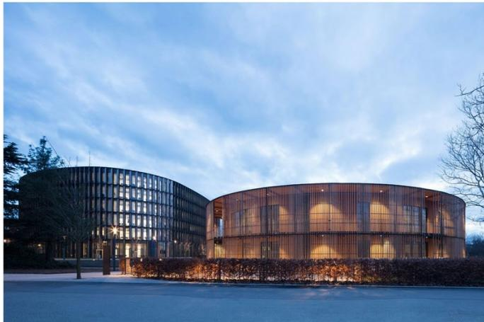
Abbildung 1: In Holzlamellen integrierte PV-Module des Technischen Rathauses Freiburg | Br. Quelle: ingenhoven associates / HGEsch
