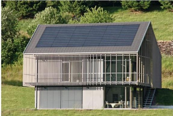
Abbildung 1: Beispiel für eine gestalterische und funktionale Integration von Photovoltaik in ein Schrägdach: energieplus schwarzwaldhaus.
