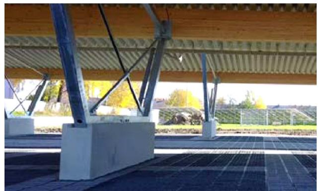
Abbildung 7: Stellplatzüberdachung mit Blechdach, Standardmodulen und großen Fundamenten.
