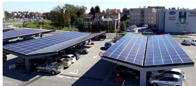
Abbildung 3: Photovoltaik-Stellplatzüberdachung: Überdachung von Stellplatzreihen mit Photovoltaikmodulen mit T-Profil-Tragwerksstruktur.
