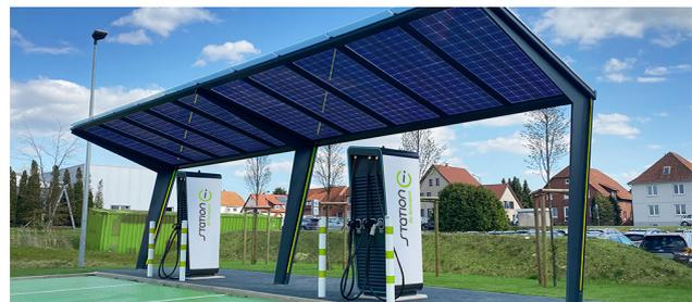
Abbildung 4: Solarer Mobilityhub für Parkplätze und E-Autos: E-Schnelladesäulen mit PV-Strom optional mit Informationsdisplay für Bürger, Paketstation, Getränkeautomat, LED-Beleuchtung, Sitzbank, W-LAN Hotspot, usw. – je nach Bedarf. Quelle: Zuweso GmbH – Für Nachhaltigkeit – www.station-i.de
